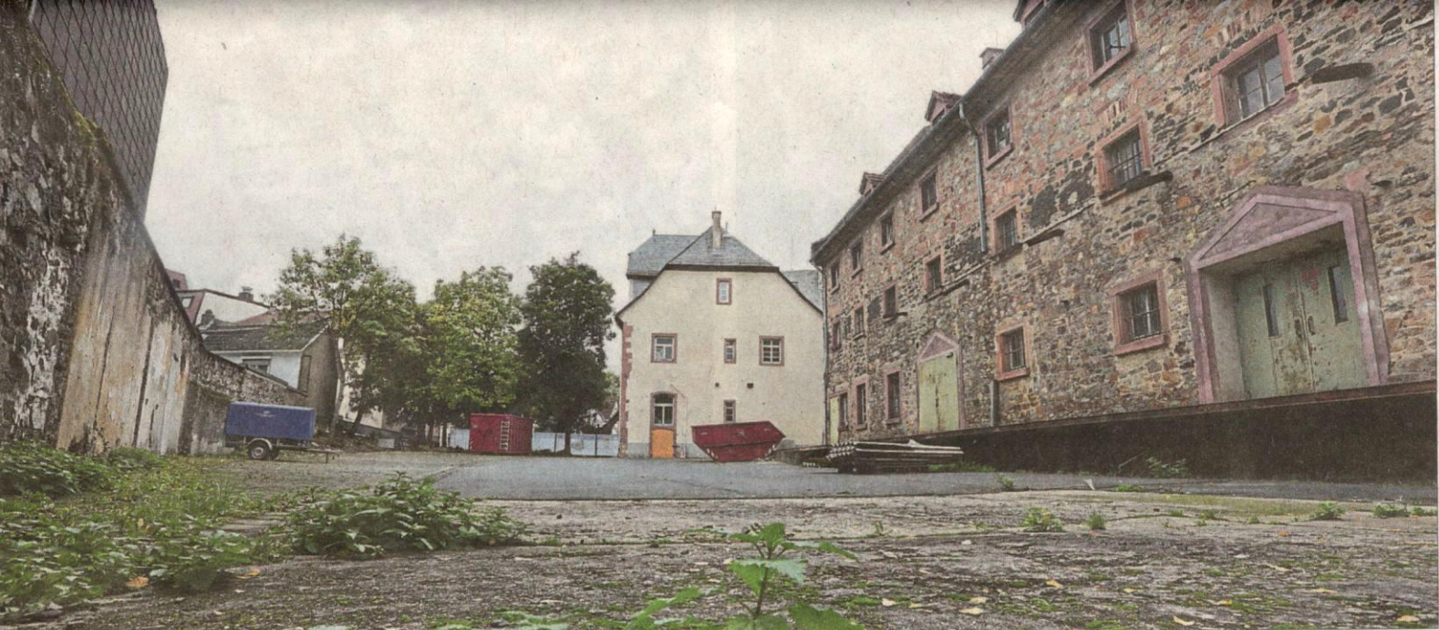
Moderne Loftwohnungen entstehen im Fabrikgebäude im Hof Kaiserstraße 118/120. Entlang der Stadtmauer wird ein Neubau errichtet.
